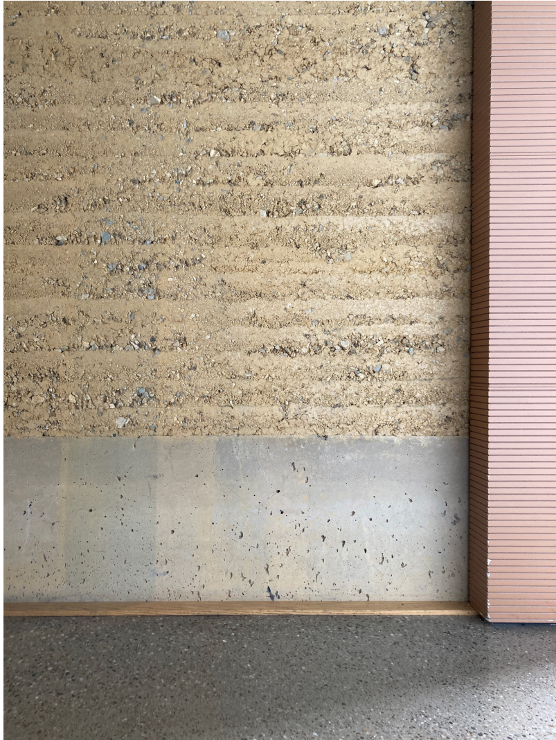
Innenansicht Erdgeschoss mit Betonsockel und Installationsleibung (rechts) © J. Schwarz
