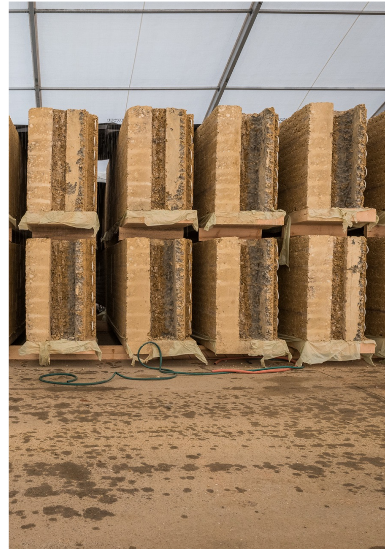
Trocknung der fertigen Elemente (inkl. Heizschlaufen innenseitig) © Emmanuel Dorsaz
