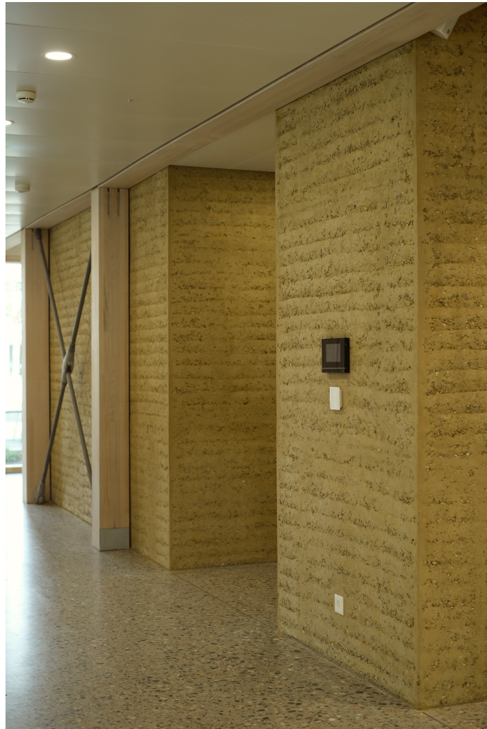
Selbsttragende Stampflehmkerne mit Primärtragwerk
