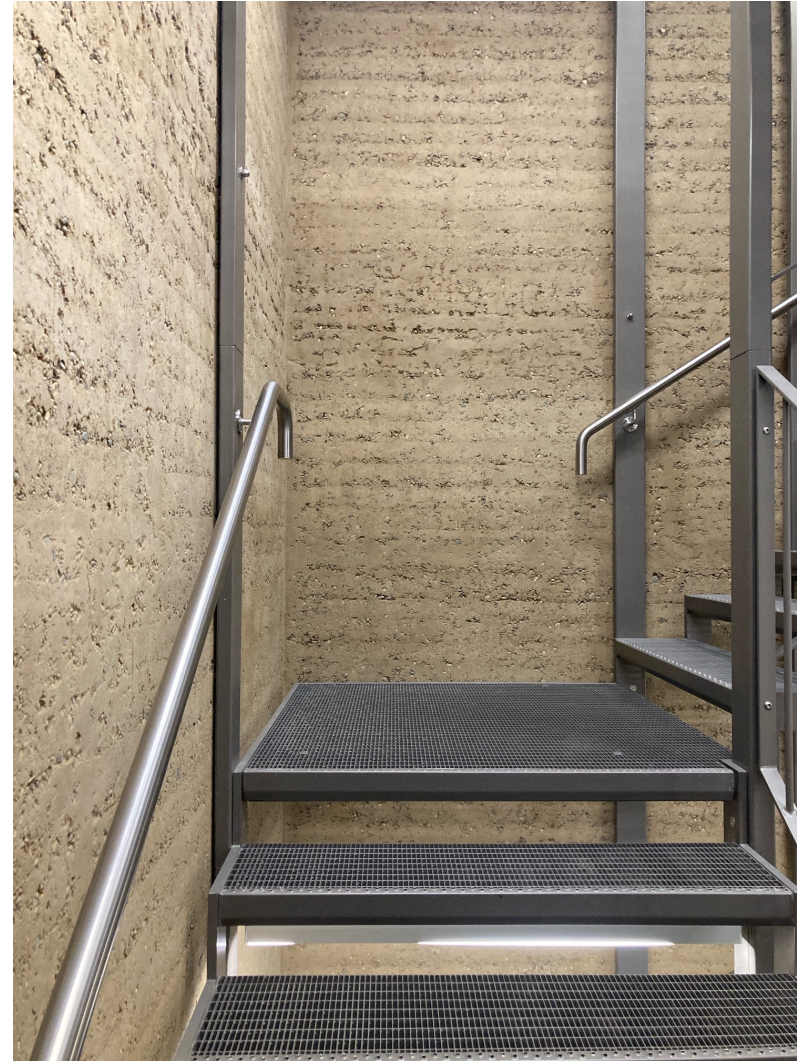
Fluchtstiegenhaus, Sanitär- und Aufzugskerne mittel Stampflehmelementen
