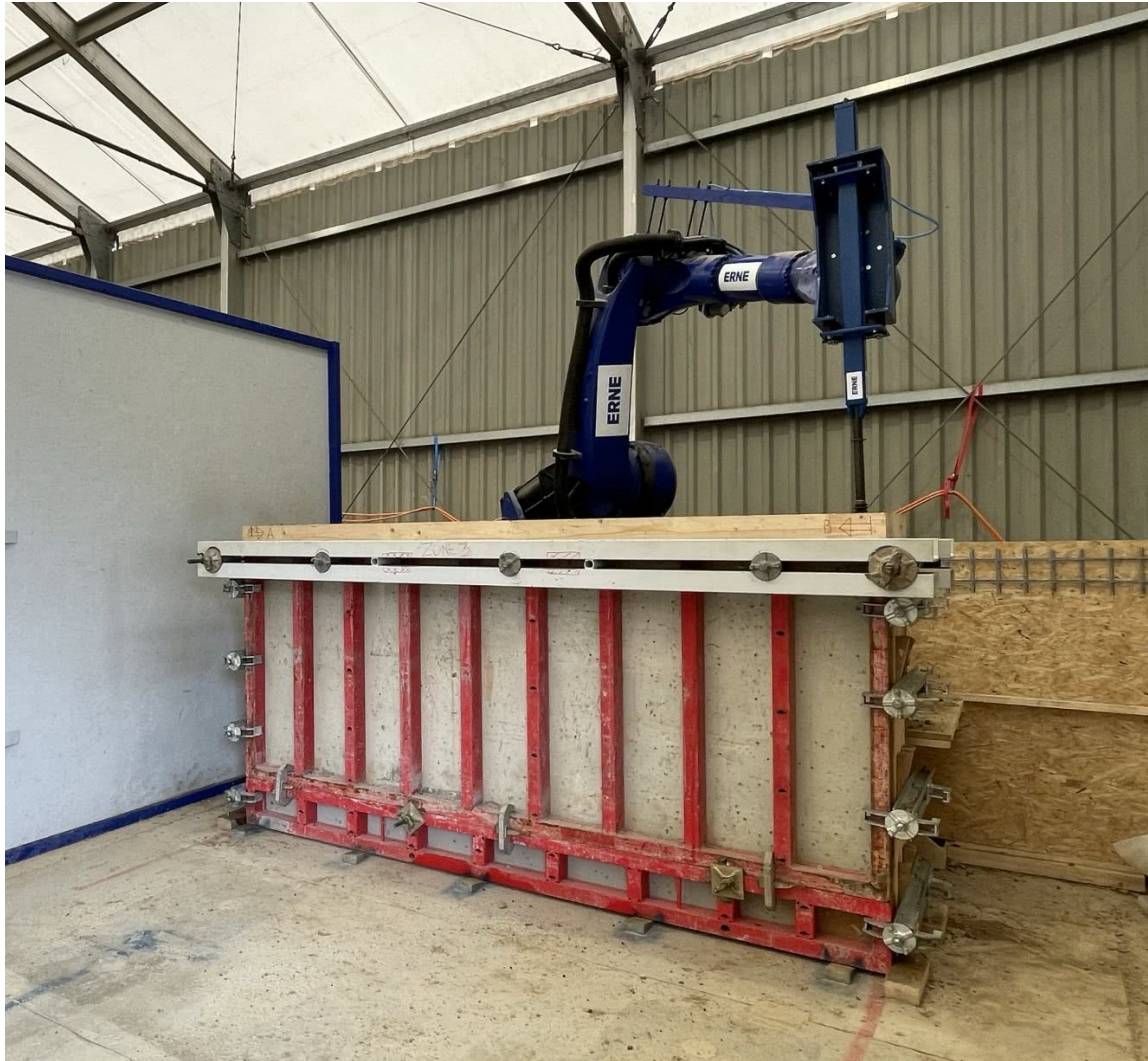
Verdichtung mittels Roboter
