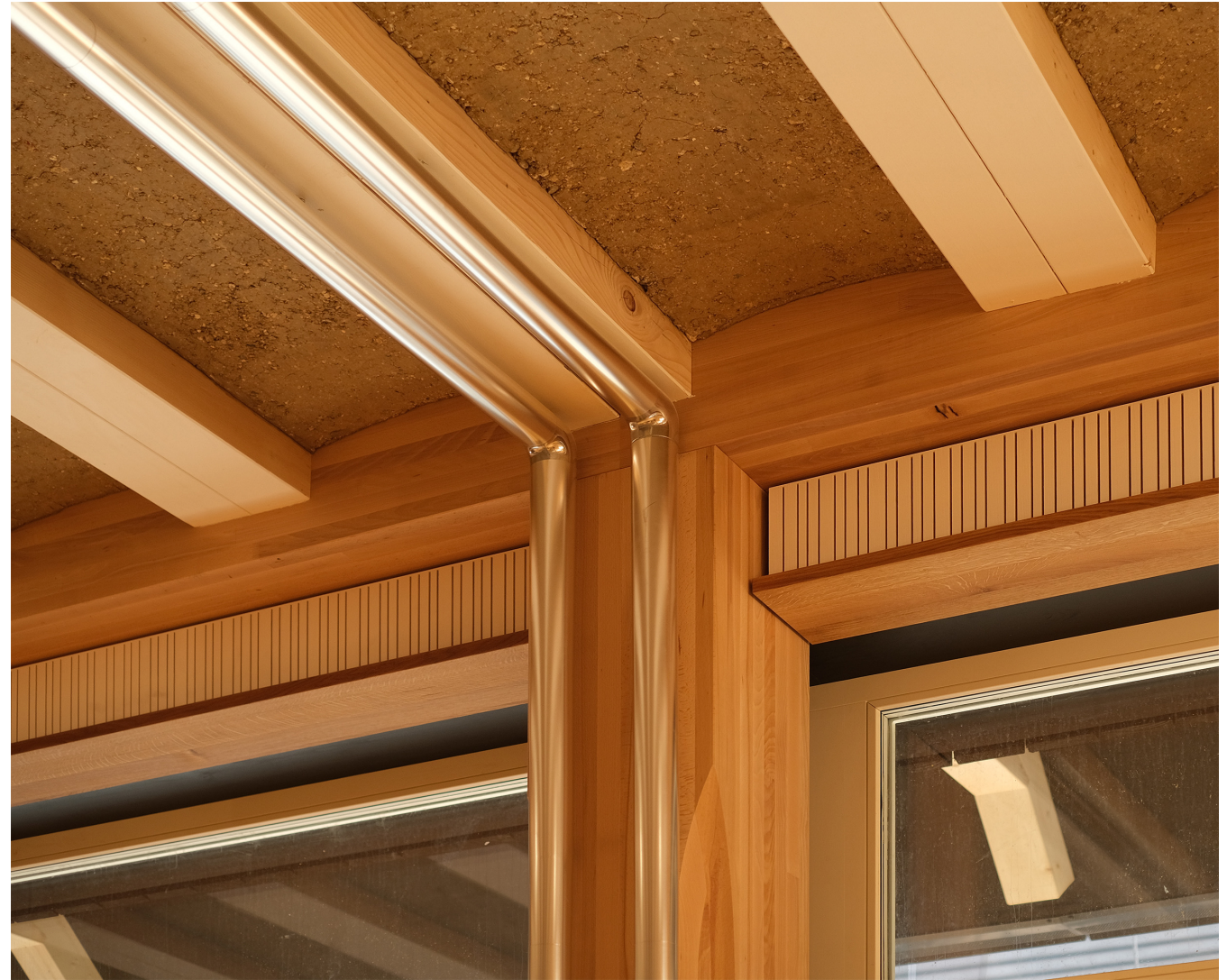
Anschlussdetail Deckenelemente auf Stütze mit Installationsführung
